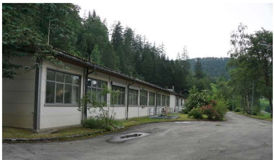
Abb. 12: Arbeitszone Colra mit dem Büro- und Werkstattgebäude im Vordergrund (STW AG für Raumplanung)
